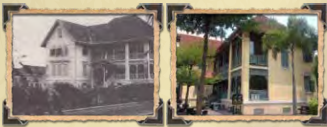
ภาพอาคารพิสมัยพิมลสัตย์ ในอดีตและปัจจุบัน
